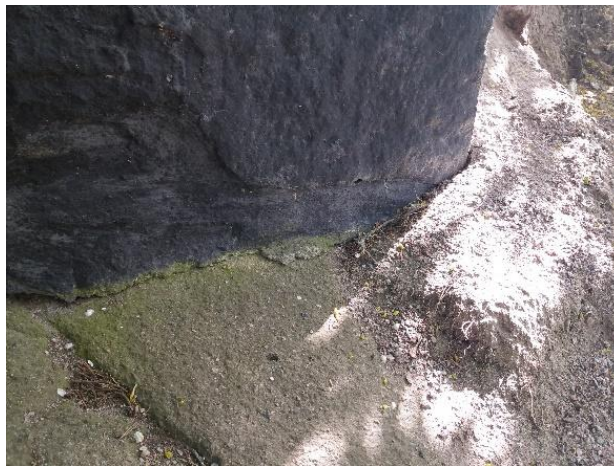
Figur 7. Mindre byggnad gjutet på berg
